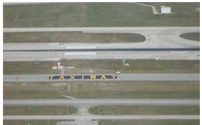
Ci-contre et page suivante : Marquages au sol plus visibles évitant toute ambiguïté possible.
